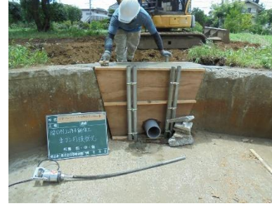
③型枠を組み、コンクリートを打設している。下の穴は浸透ますへの排水口。
