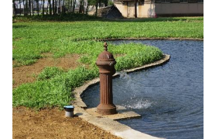
⑤水中ポンプを利用して、通水試験を行い、吐出状況の確認をした。
