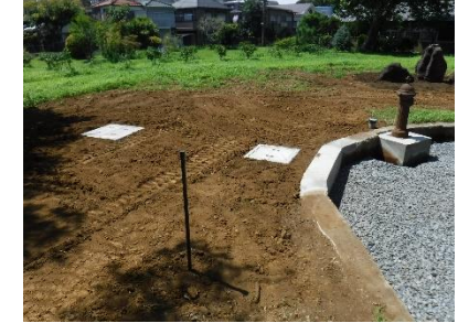
⑤施工後 土で埋め戻したため、地上からは、ますの蓋が見えない。
