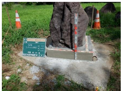
③台座の石はコンクリートで固定
