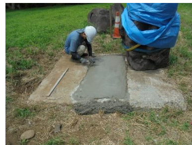
②基礎となる土台を形成中
