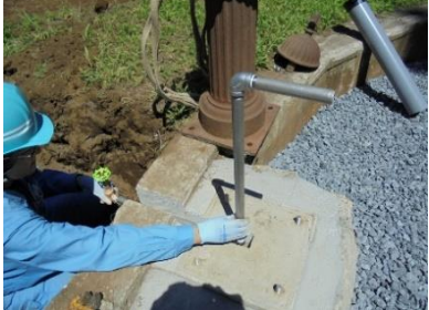
②給水管や給水バルブを設置。
