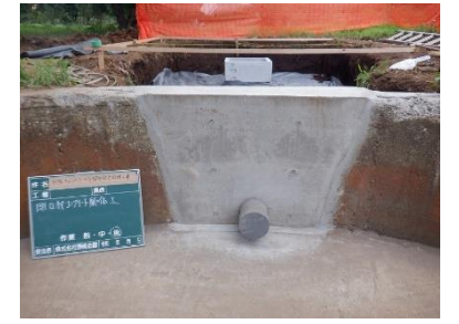
④施工後 コンクリートの躯体（壁）が出来た。
