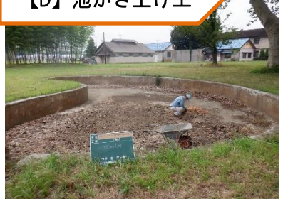
①施工前 まずは池の掃除から。泥や落ち葉を掻きだしている。
