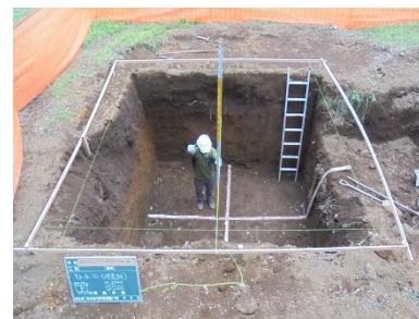
③浸透ますはかなり大型のものをつかった。写真は砕石やますを入れる前。
