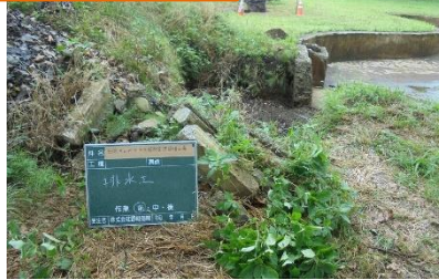
①施工前 壊れている池の躯体（壁）の写真左側に浸透ますを設置する。
