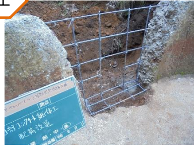
②鉄筋コンクリートの躯体（壁）をつくるための配筋設置したところ。
