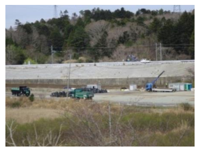
常磐線復旧工事は進んでいる
