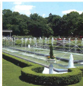
神代植物公園 噴水工事
