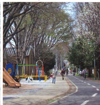
狭山境緑道 園路改修工事
