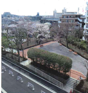
都営中原 アパート外構改善工事
