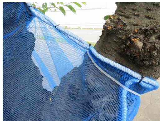
樹木の上部は結束バンドなどで、すき間が出ないように固定している。
