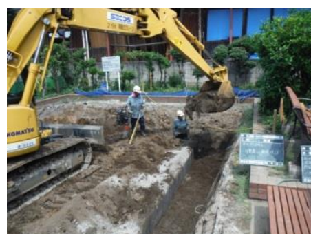
<7>埋め戻し状況
