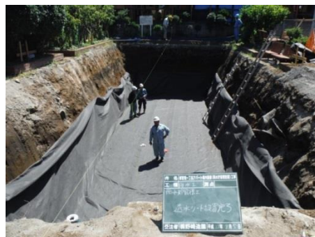
<2>貯留槽本体を設置する前に、透水シートを設置
