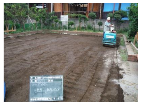
<8>埋戻し後、転圧状況（この後、ダスト舗装仕上げて終了）
