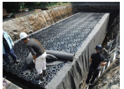
<4>本体組立後、透水シートを設置中
