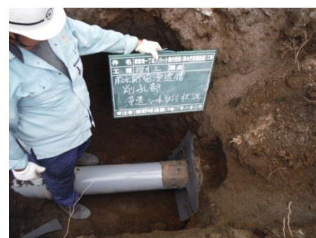
<6>本体から下水管への接続管、取り付け状況
