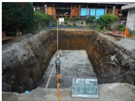
<1>貯留槽を設置する穴を掘り、底面に基礎となる碎石を敷き、締め固めた状態
