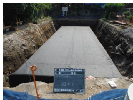
<5>本体に透水シートを設置後
