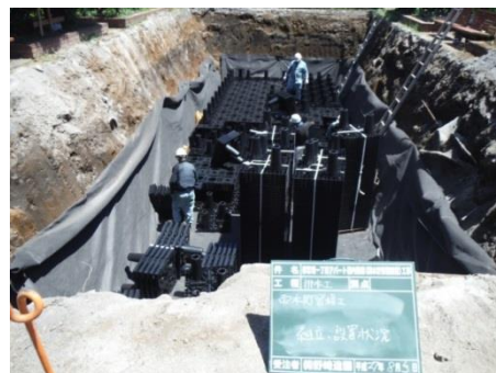
<3>人力施工により、本体の組み立て
