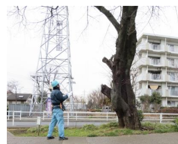
外観診断の一例
