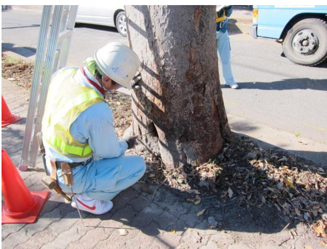
街路樹(ケヤキ)の腐朽度合の樹木調査
